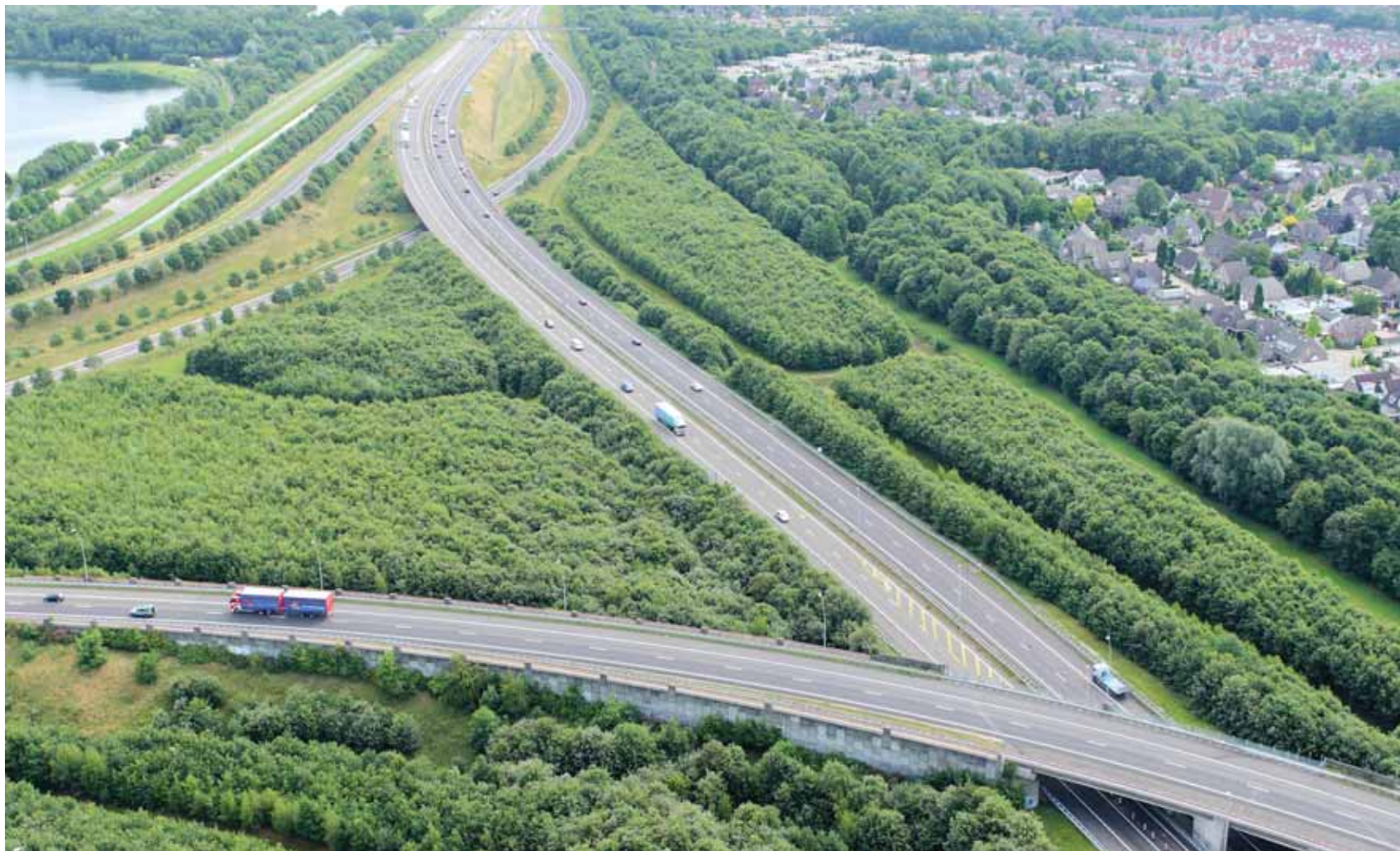
Luchtfoto van de A2 als parkway
