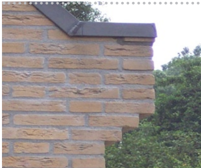
uitkragend metselwerk (“oor”)
